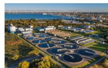
Paljassaare reoveepuhastusjaam, kompostimisväljakud ja heitveelabor
