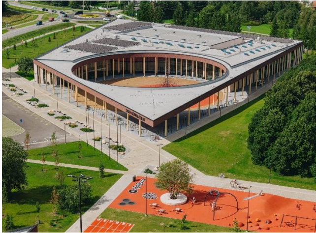
Saku Gümnaasiumi õppehoone ja spordikompleks (teostaja: Nordecon AS, foto: Tõnu Tunnel)
