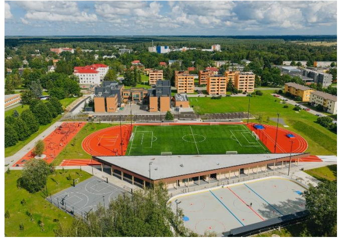
Saku Gümnaasiumi õppehoone ja spordikompleks (teostaja: Nordecon AS, foto: Tõnu Tunnel)
