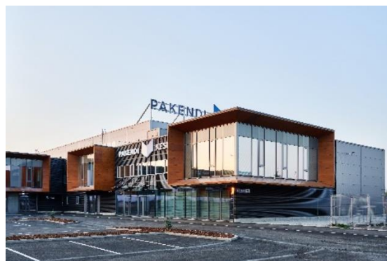
Fotol: Pakendikeskuse logistikakeskus (teostaja Nordecon Betoon OÜ)
