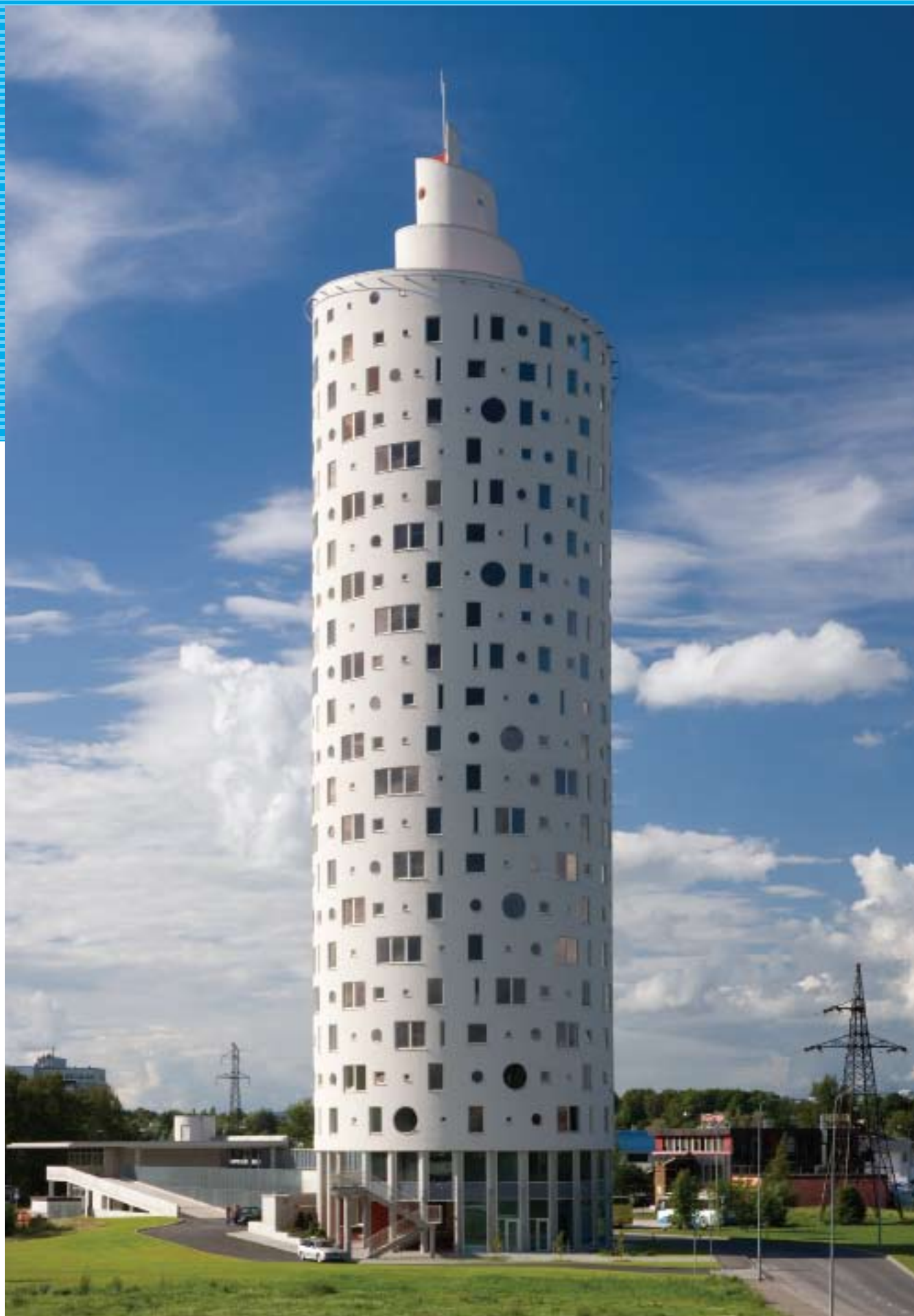
Objekt: Elu- ja ärihoone (Tigutorn) Asukoht: Väike-Turu tn 5, Tartu Tellija: Nordecon Ehitus AS Arhitekt: Arhitektuuribüroo Künnapu & Padrik OÜ Tööde aeg: märts 2006 – märts 2008 Ehitaja: Nordecon Ehitus AS Projektijuht: Ain Rebane
