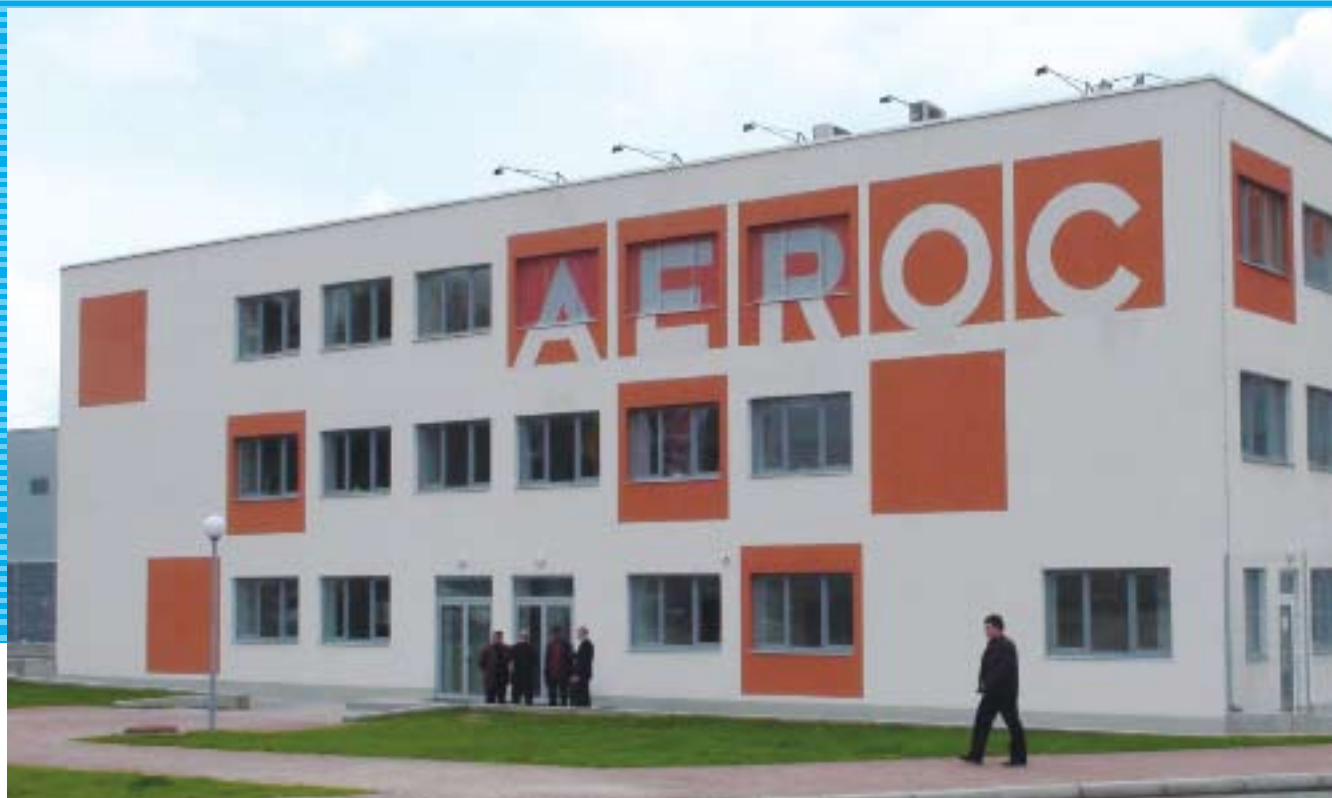
Objekt: Gaasbetoonplokide tehas AEROC Asukoht: Berezan, Kiievi oblast, Ukraina Tellija: AEROC Arhitekt: EA Reng Projekt Tööde aeg: veebruar 2007 – november 2008 Ehitaja: Eurocon Ukraine LLC Projektijuht: Viljar Aus
