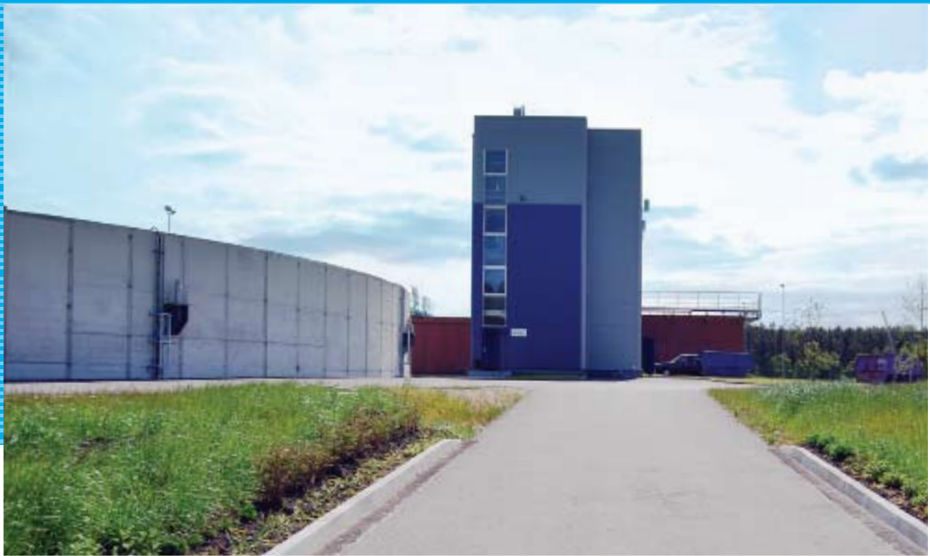
Objekt: Sloka heitvee puhastusjaama mudaväljak Asukoht: Jurmala, Läti Tellija: YIT Construction SIA Tööde aeg: august 2007 – juuni 2008 Ehitaja: Nordecon Infra SIA Projektijuht: Marko Aalberg, Janis Veckaktins
