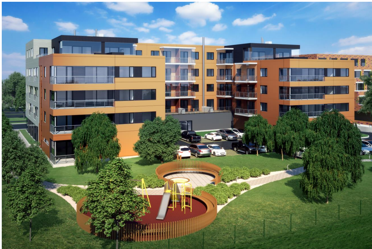
KOLMANDAS KVARTALIS KÄIVITATUD KORTERIARENDUSPROJEKT, SÕPRUSE PST. 33 EHTUS TALLINNAS KRISTIINE LINNAOSAS. ARHITEKT VELLE KADALIPPU PROJEKTEERITUD U-KUJULIST HOONED ILMESTAVAD ERINEVAD FASSAADIKATTEMATERJALID, KLAASLIFTID NING PRIVAATNE JA RIKKALIKU HALJASTUSEGA SISEÕU.
