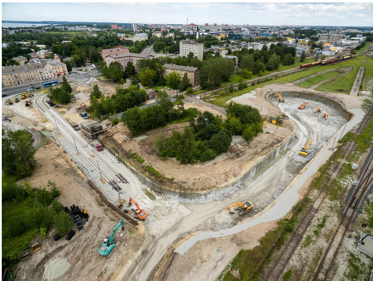
AS MERKO EHITUS EESTI, KMG INSENEREHIITUSE AS JA RATATEK OY KONSORTSIUMI POOLT TALLINNA 4. TRAMMILIINI TARISTU PROJEKTEERIMISE JA REKONSTRUEERIMISE TÖÖDE RAAMES RAJATAV TRAMMITEE PIKENDUS PETERBURI TEE 2 KINNISTULE, KUHU EHITATAKSE KA TRAMMIDE TAGASIPÖÖRDERINGIGA.
