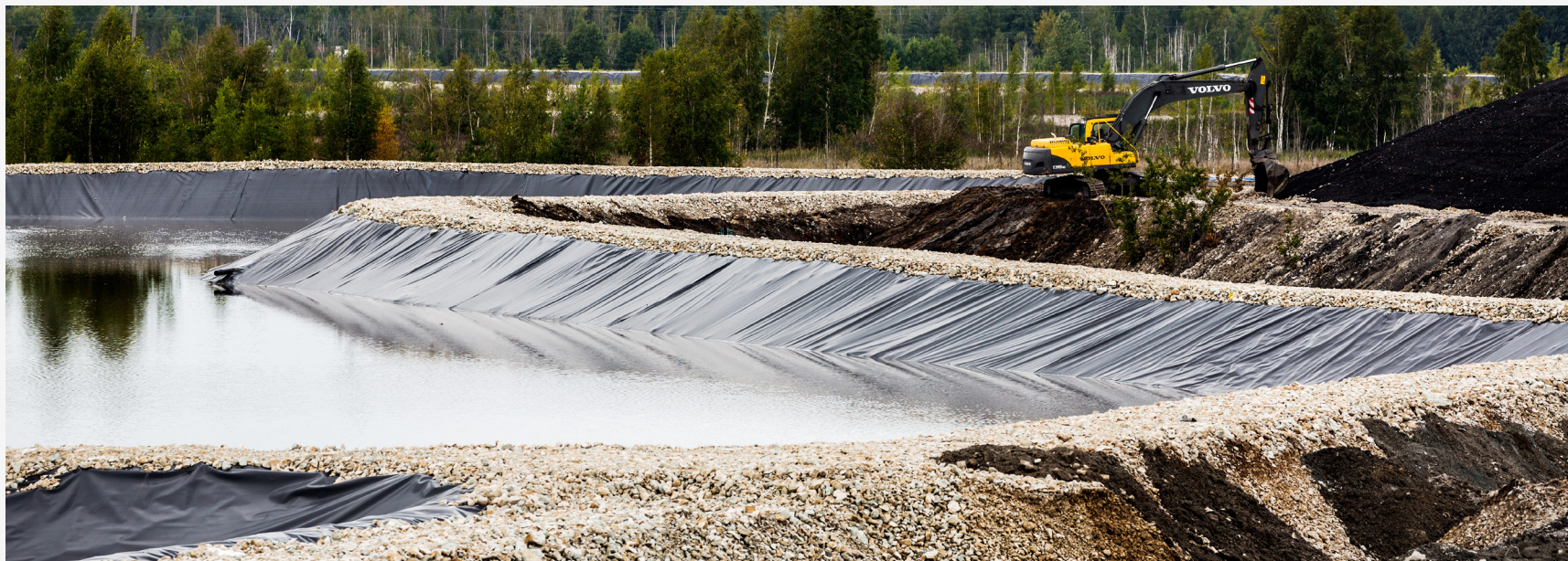
2013. AASTAL JÄTKUSID KOHTLA-JÄRVEL TÖÖSTUSJÄÄTMETE JA POOLKOKSI PRÜGILA SULGEMISE TÖÖD, MILLE RAAMES TEISALDATAKSE 6 MILJONIT KUUPMEETRIT MÄEMASSIIVI.
