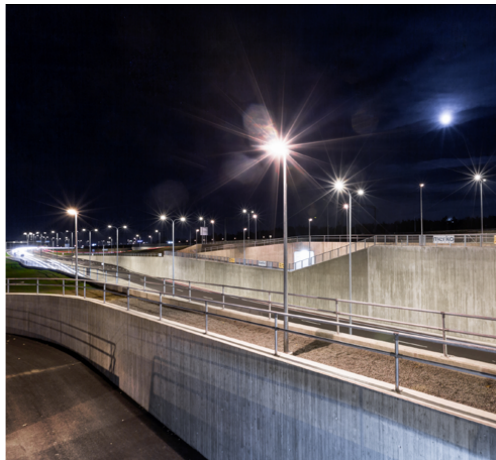
„AASTA BETOONEHITIS 2013“ ÜLEMISTE LIIKLUSSÕLME EHITUSTÖÖDEL KASUTATI 42 000 KANTMEETRIT BETOONI
