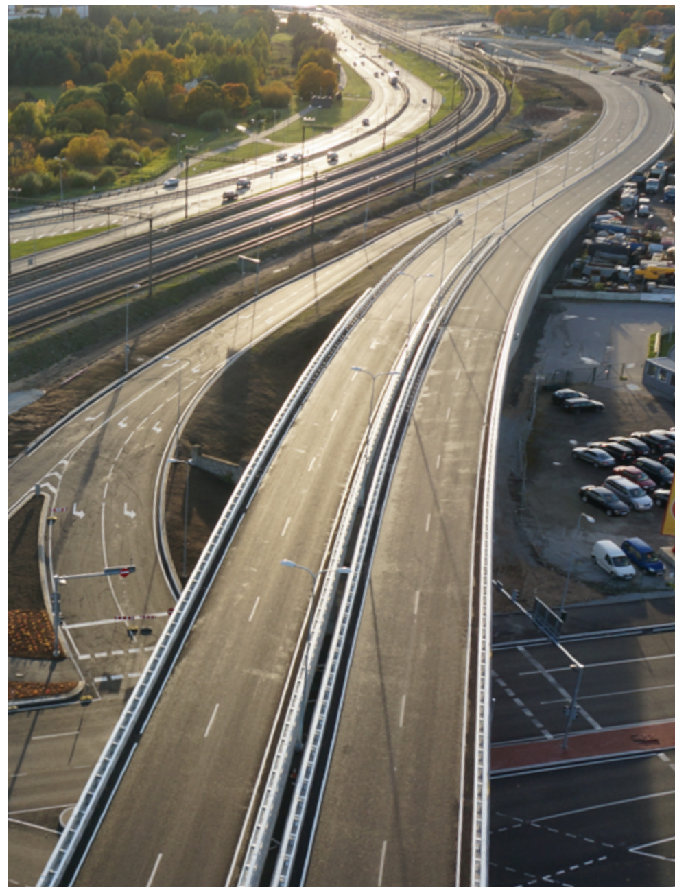
ÜLEMISTE LIIKLUSSÕLMES RAJATI KOKKU 7,5 KM UUSI JA REKONSTRUEERITUD 1,2 KM TEID, PAIGALDATUD ASFALDI PINDALA ULATUS KOKKU 155 000 RUUTMEETRINI.
