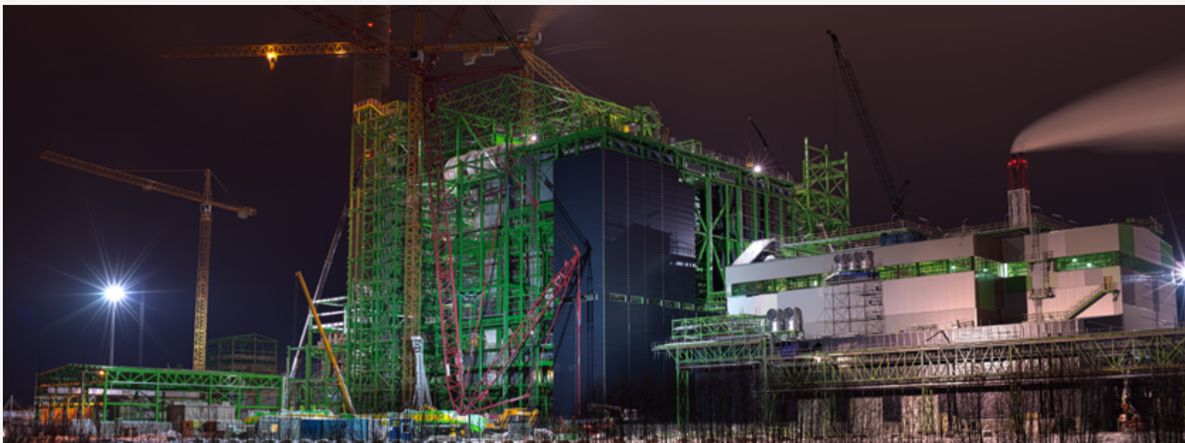
2014. AASTAL VALMIV TÖÖSOLEV SUUROBJEKT: IDA-VIRUMAAL AUVERES EESTI ELEKTRIAAMA TERRITOORIUMILE RAJATAVA PÕLEVKIVI JA BIOKÜTUSE ETTEANDESÜSTEEMIDE ELEKTRISÜSTEEMIDE EHITUSTÖÖD KOOS VAJALIKE SEADMETEGA.
