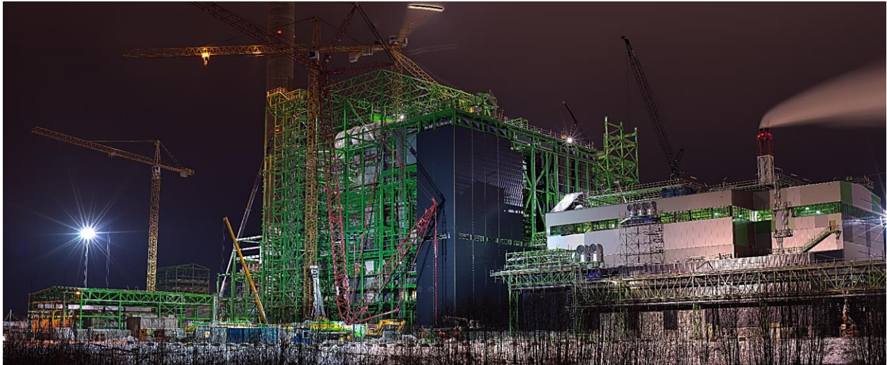
2014. AASTAL VALMIV TÖÖSOLEV SUUROBJEKT: IDA-VIRUMAAL AUVERES EESTI ELEKTRIAAMA TERRITOORIUMILE RAJATAVA PÕLEVKIVI JA BIOKÜTUSE ETTEANDESÜSTEEMIDE ELEKTRISÜSTEEMIDE E HITUSTÖÖD KOOS VAJALIKE SEADMETEGA
