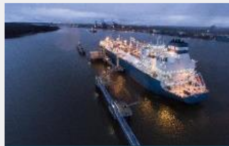
KLAIPĖDA LNG TERMINAL
