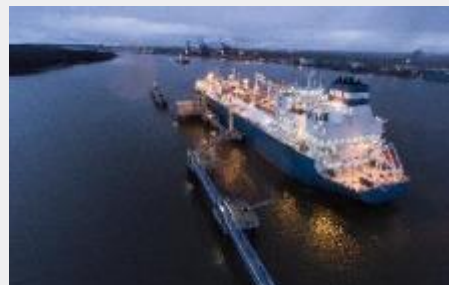
KLAIPĖDA LNG TERMINAL
