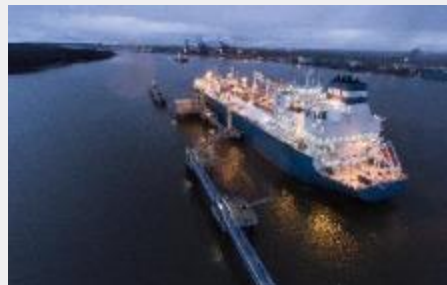
KLAIPĖDA LNG TERMINAL
