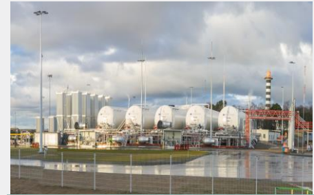
KLAIPĖDA SMALL-SCALE LNG TERMINAL
