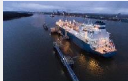
KLAIPĖDA LNG TERMINAL
