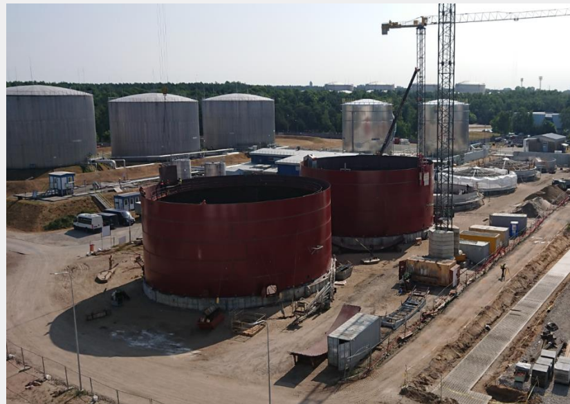
Šviesių naftos produktų 2 x 10 000 m 3 ir 4 x 5 000 m 3 rezervuarų parko statyba - per 2018 m. 6 mėn. išlieti pamatai visiems rezervuarams.
