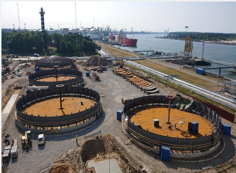
Šviesių naftos produktų 6 x 20 000 m 3 rezervuarų parko statyba - pamatų liejimo darbai keturiems rezervuarams.
