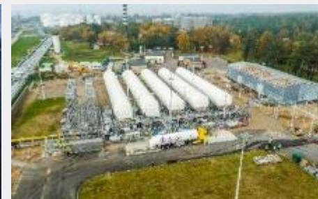
KLAIPĖDA SMALL-SCALE LNG TERMINAL
