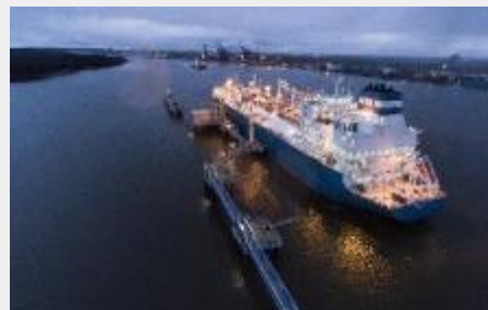
KLAIPĖDA LNG TERMINAL
