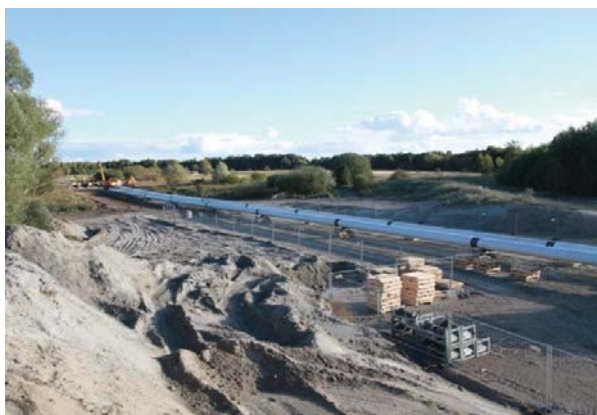
Dujotiekis: vaizdai iš statybų aikštelės
