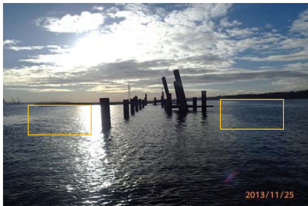
Krantinė: vaizdai iš statybų aikštelės
