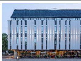
Office building Palangos str. 4/ Vilniaus str. 33 Vilnius
