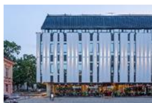
Office building Palangos str. 4/ Vilniaus str. 33 Vilnius
