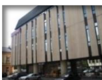
Office building Palangos str. 4/ Vilniaus str. 33 Vilnius
