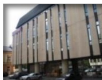
Office building Palangos str. 4/ Vilniaus str. 33 Vilnius
