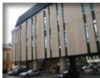
Office building Palangos str. 4/ Vilniaus str. 33 Vilnius
