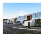
„Dommo business park“ Rīga Latvia
