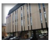
Office building Palangos str. 4/ Vilniaus str. 33 Vilnius
