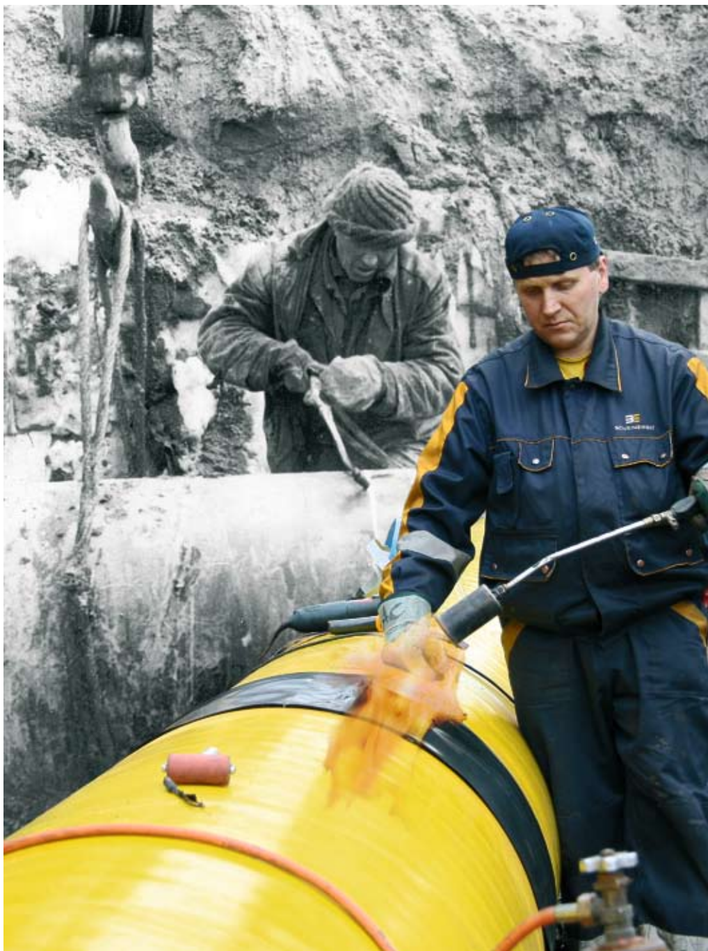
Gāzesvada būvniecība, 1962. un 2007. gads.
